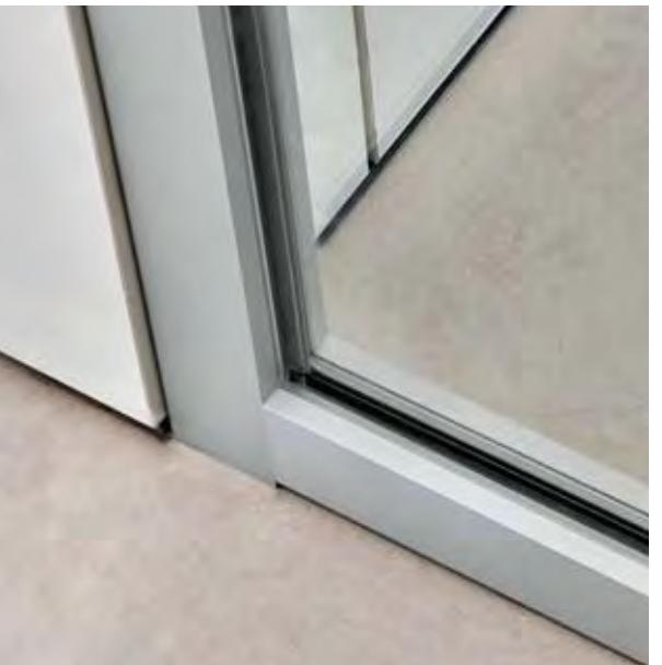
Il profilo di base incernierato che permette l'accesso frontale ai piedini di regolazione dei vetri è solo una delle tante caratteristiche che rendono il sistema parete VELOX estremamente funzionale ed essenziale
