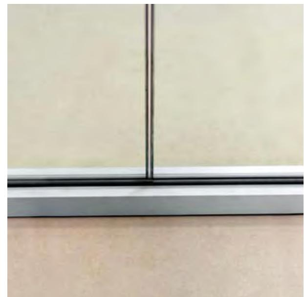
Altra soluzione per la giunzione tra le lastre di vetro è l'inserimento di un profilo in alluminio con sezione ad 'H'
