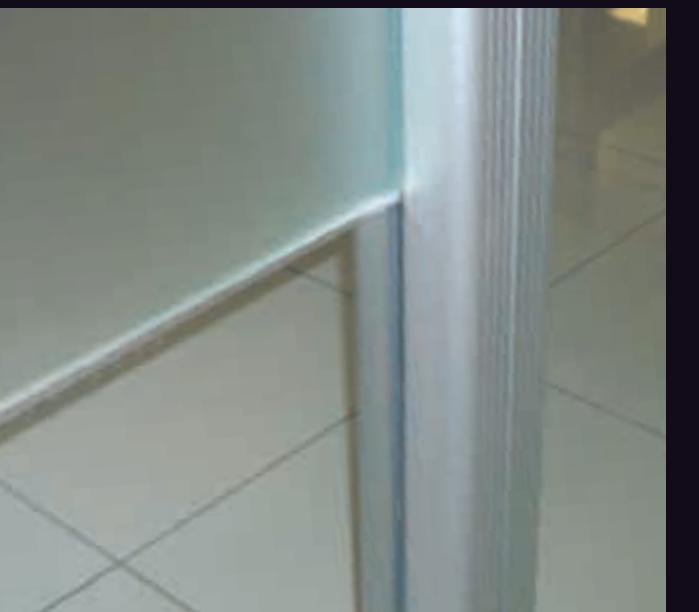
Soluzione con vetro singolo a profilo leggero, permette la realizzazione di grandi spazi vetrati, alternando parti acideate e trasparenti mantenendo una veste leggera e pulita.
