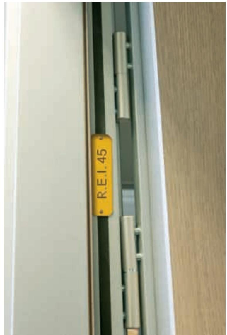
Porte tecniche resistenti al fuoco da 30 a 120 minuti e fonoisolanti da 32/46 Db.
